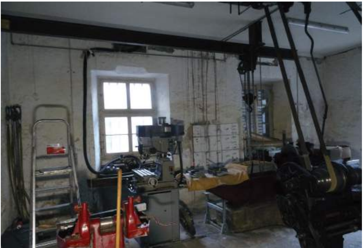
Risalit EG, nicht unterteilt, Wand West
