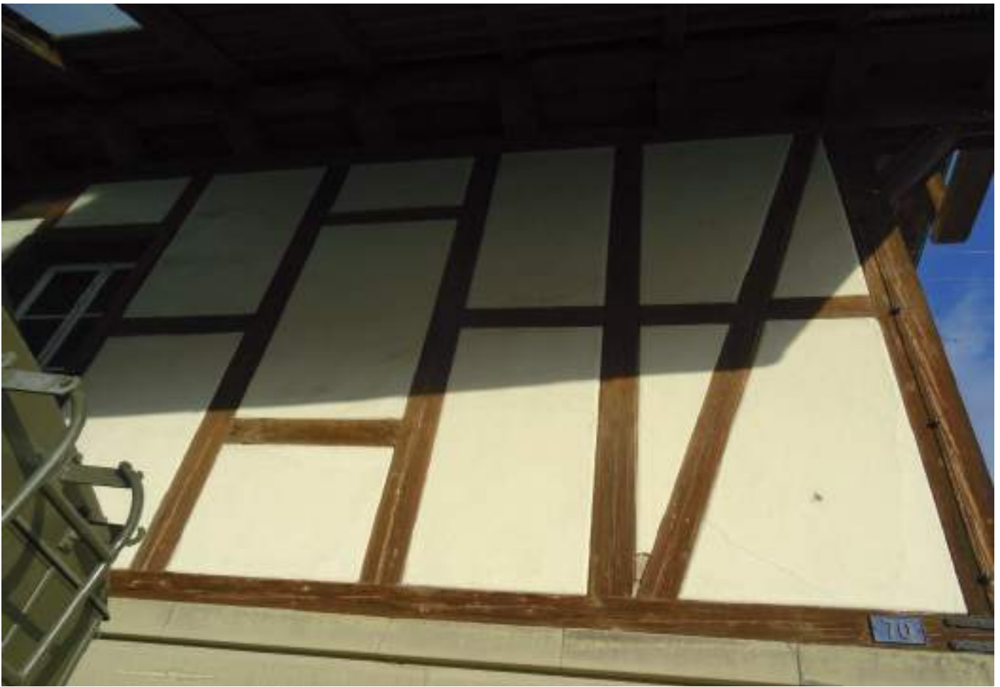
Vermauertes OG-Fenster
