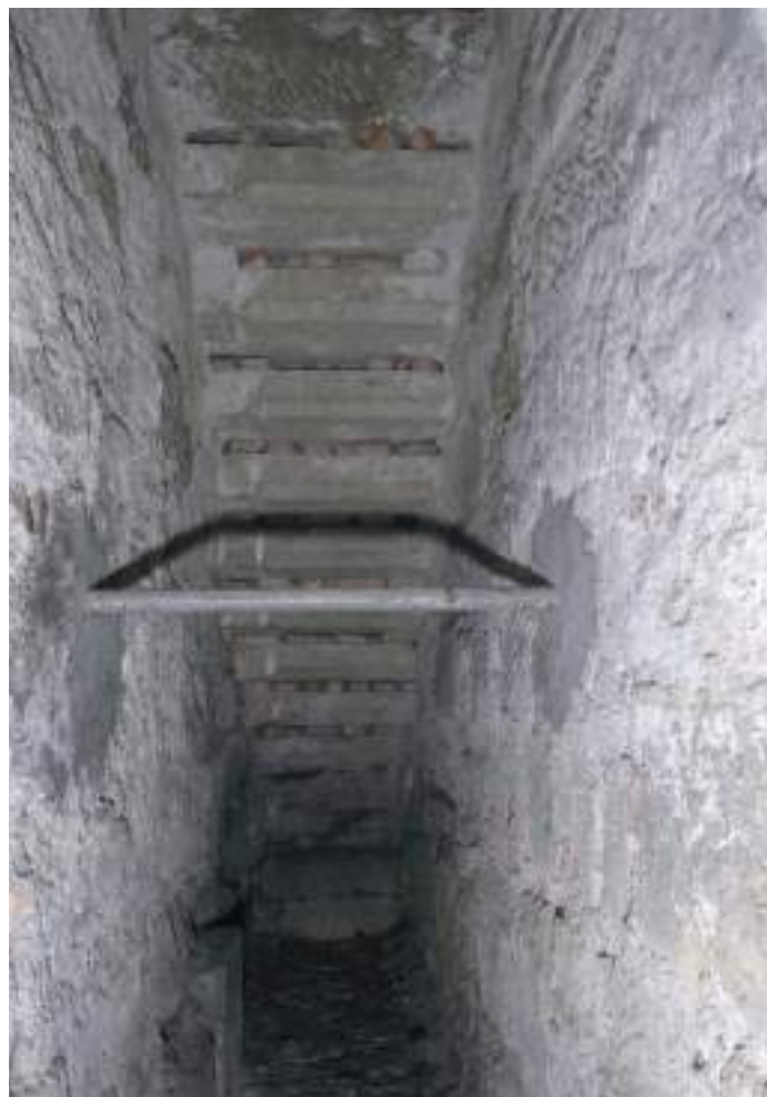
Nordtreppe unterer Teillauf, Untersicht mit wiederverwendeten Tritten Oberer Teillauf
