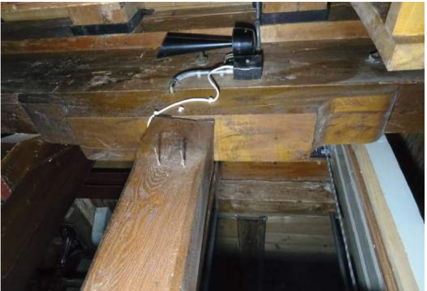
EG, Stützenkopf einer nachträglich zwischengestellten Stütze
