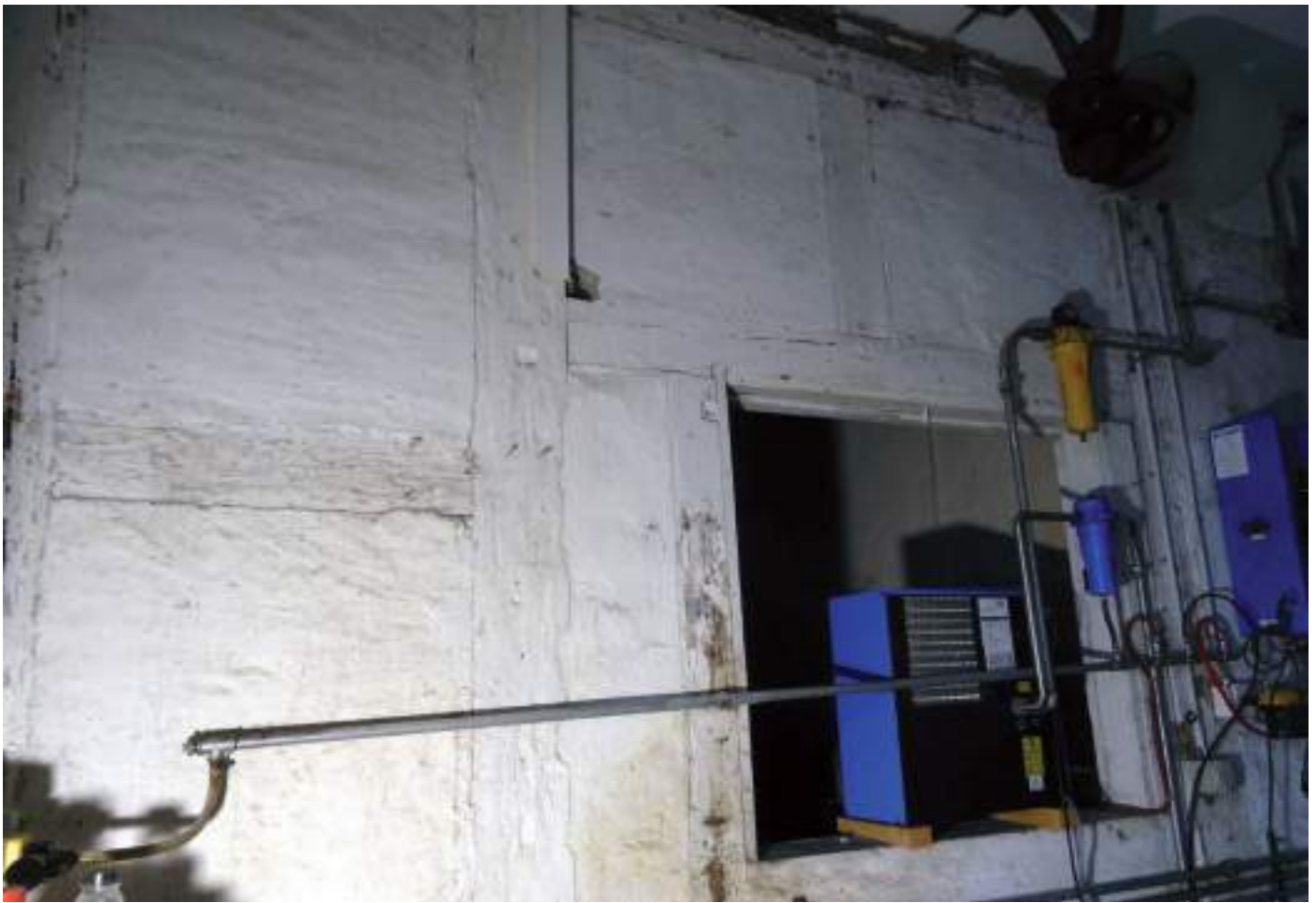
Risalit Süd EG, Wand zum Hauptbau
