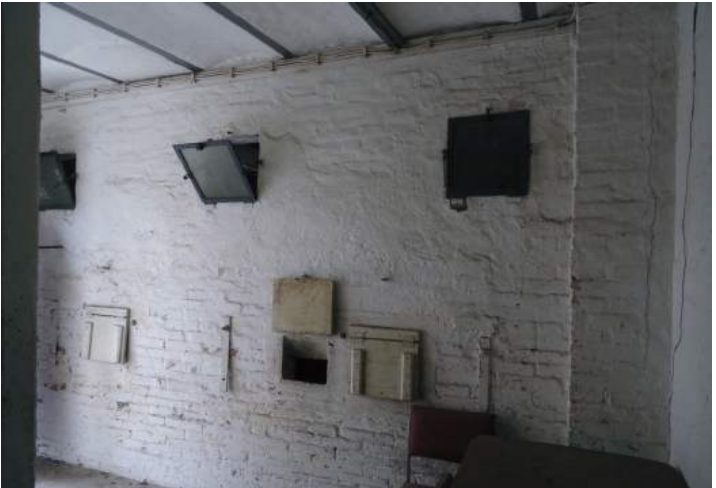
E1 Westwand mit unteren Öffnungen zur Futterkrippe und oberen Lüftungsöffnungen
