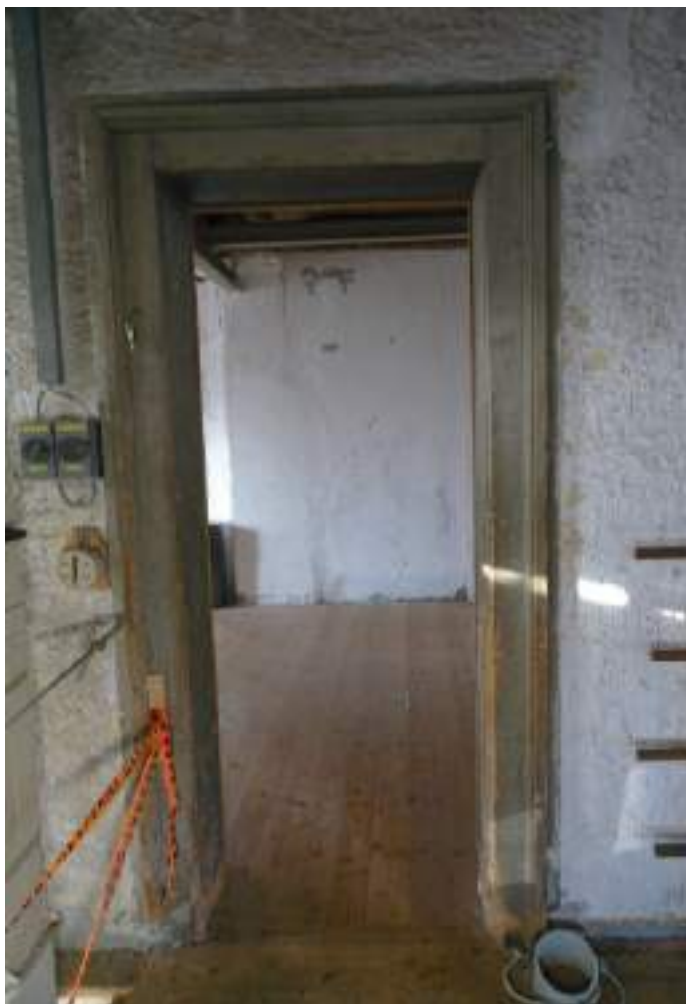
Risalitsüdwand 2. OG, zu Wohnungseingangstür erweitertes urspr. Fenster, Aussenseite
