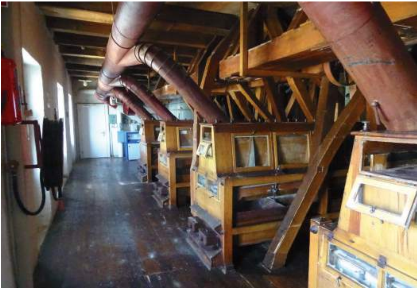
2. OG, Westschiff, Blick Richtung Norden, Nordabschnitt
