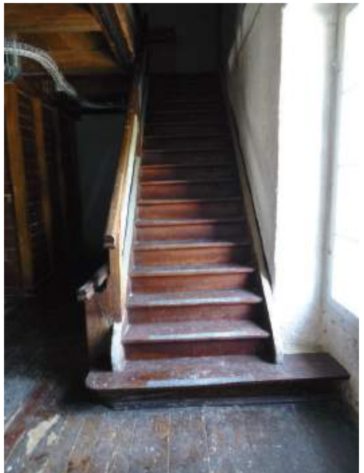
Treppe an der Westfassade, Lauf vom 2. ins 3. OG
