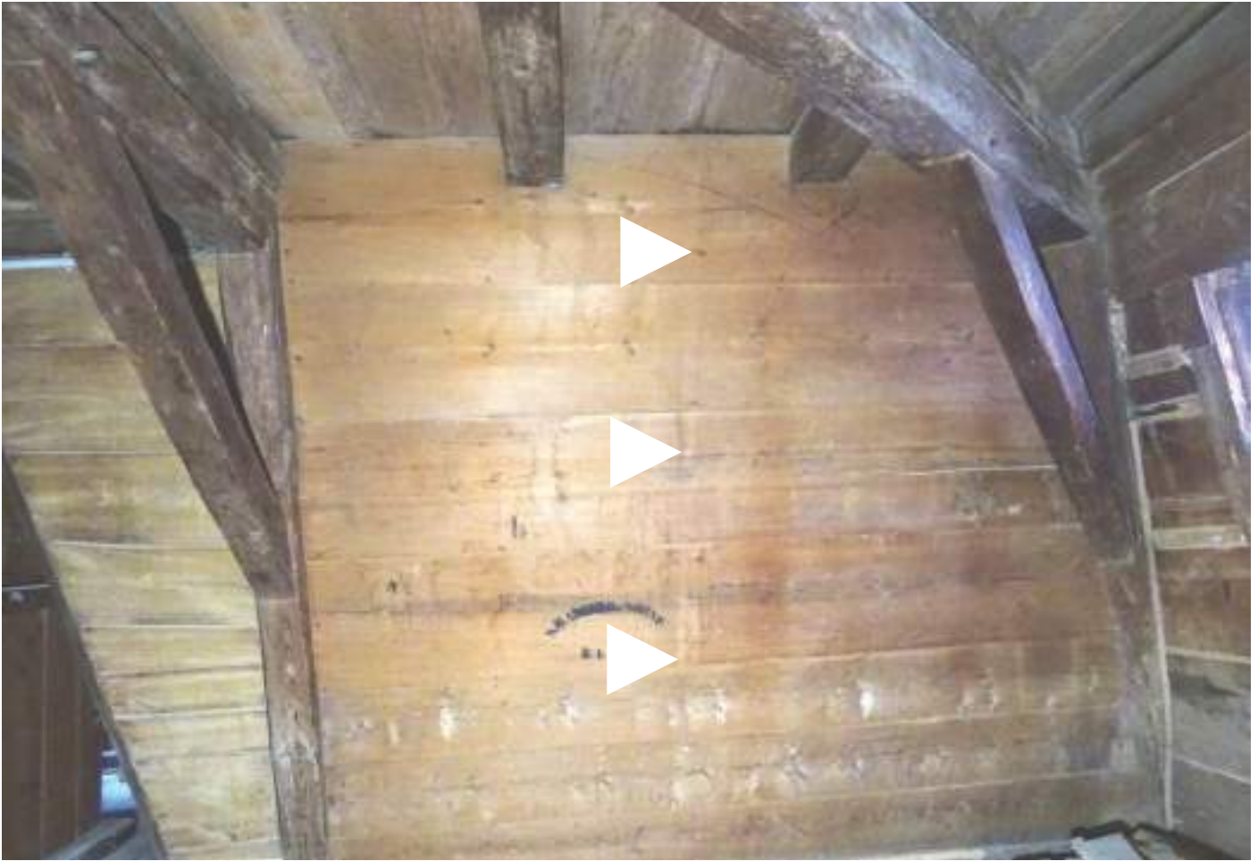
Risalitostwand 3. OG, mit Bedruck der Kammerwand
