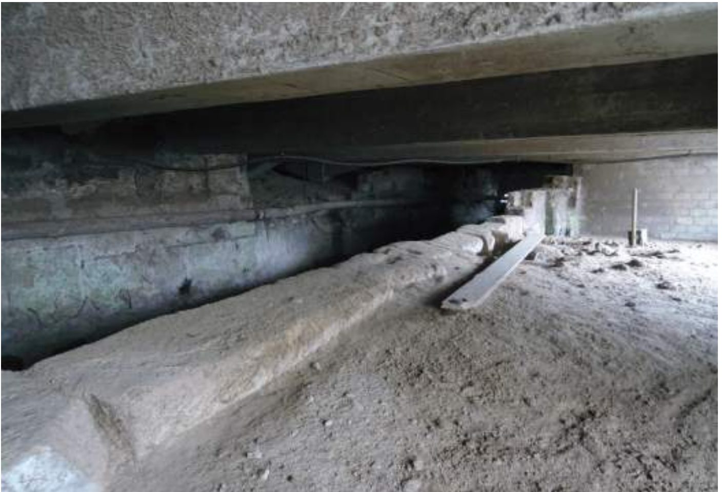
Der Mühlekanal im Nordabschnitt der ehemaligen Papiermühle
