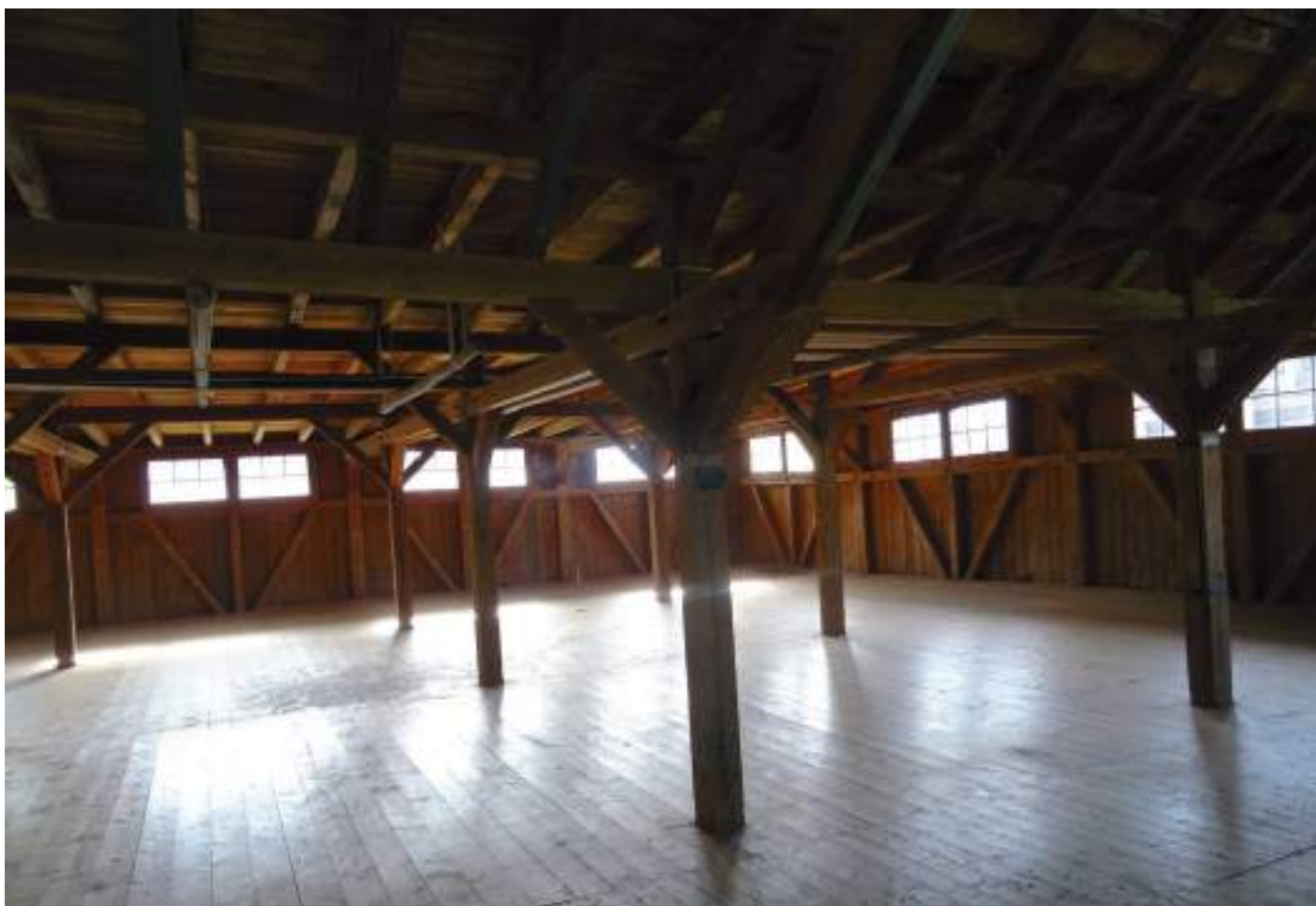
Halle 20, Obergeschoss, Blick Richtung Osten
