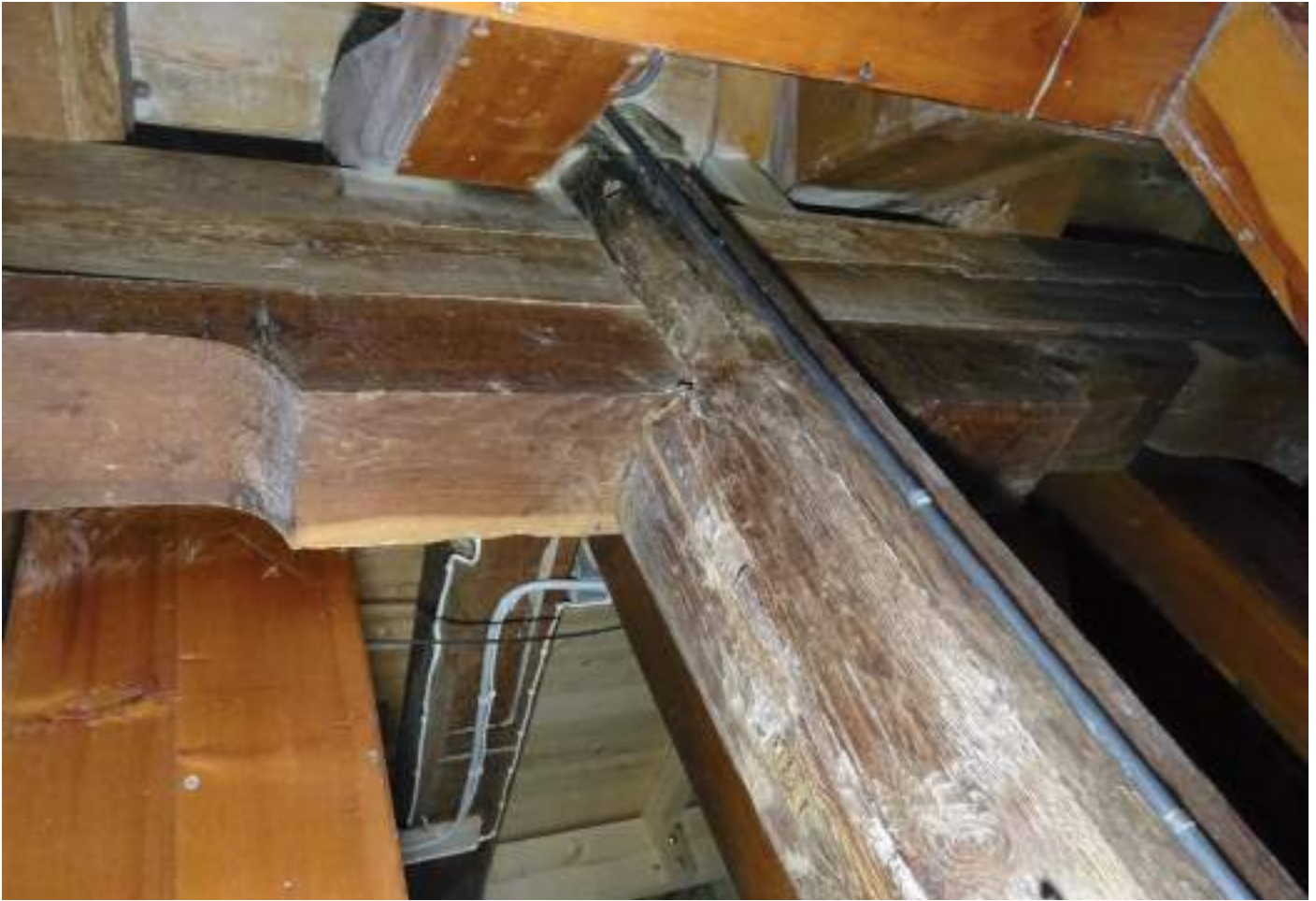
EG, bauzeitlicher Stützenkopf
