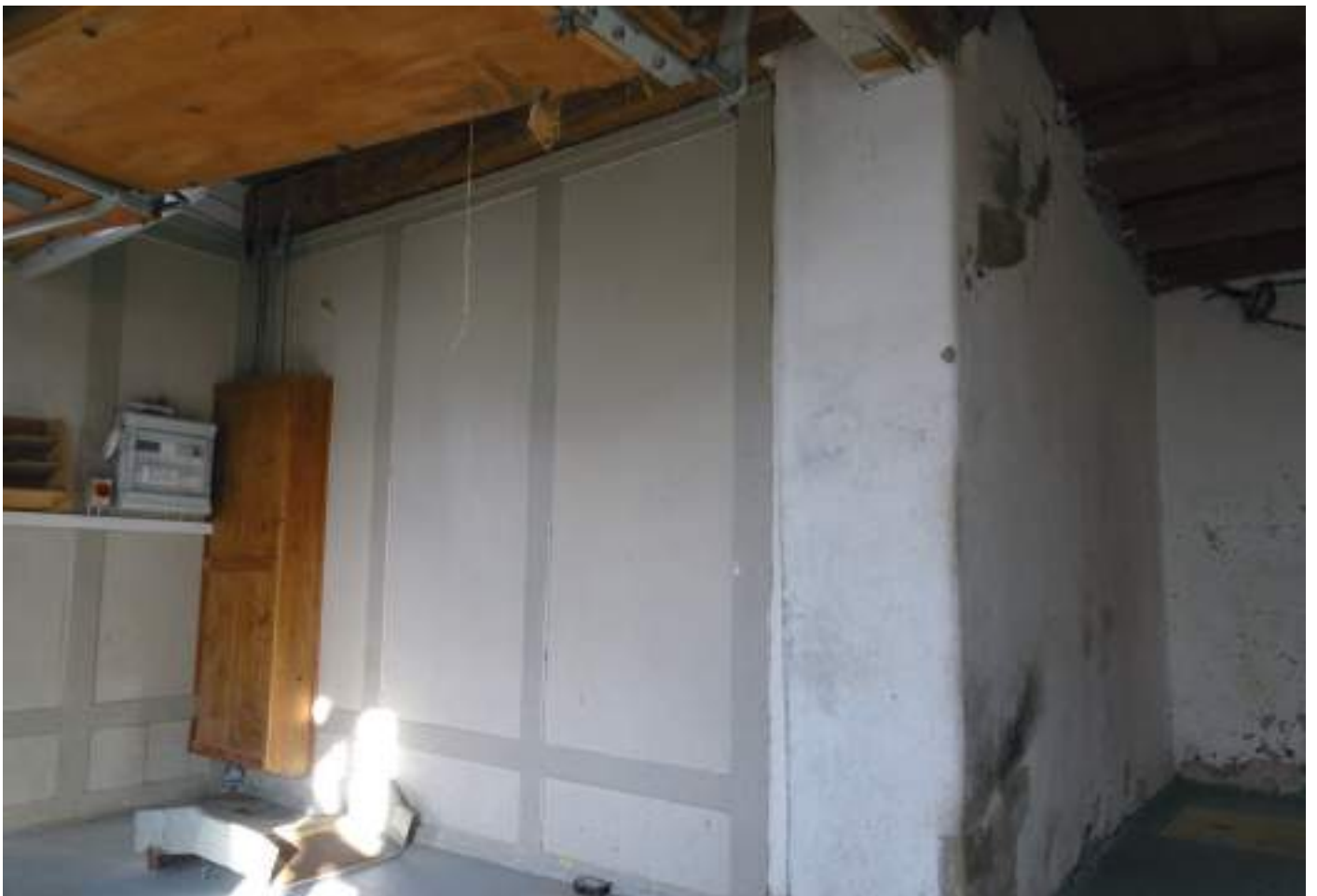
Südrisalit, 1. OG, Nordostecke mit spätklassizistischen Täfern 2. Hälfte 19. Jh.
