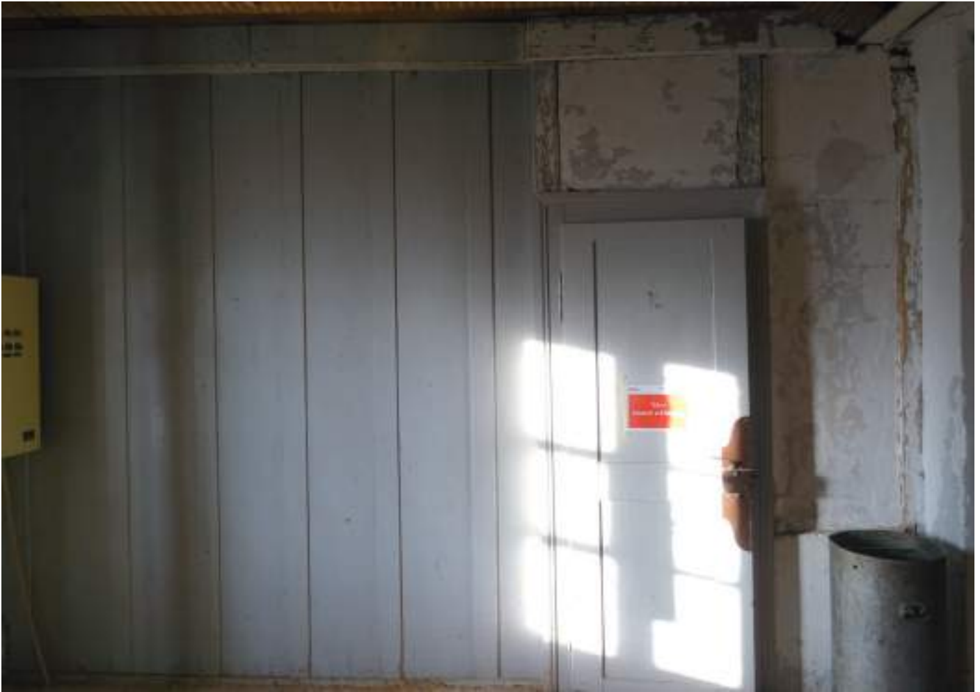
Südrisalit 2. OG, Raum B, Wand Nord
