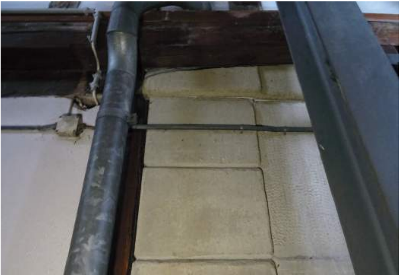
Nordfassade. Lisene am Übergang Sandstein-Fachwerkwand
