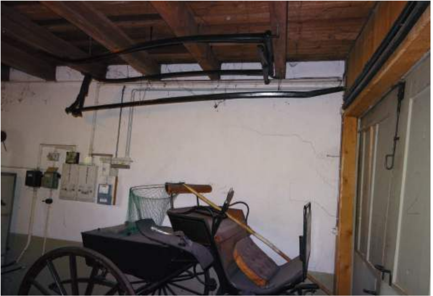
E9, Südwand und rechts Tor zur Lastwagengarage E8
