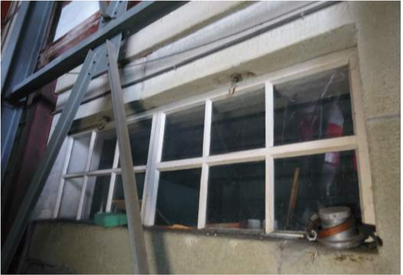
Fenster EG, Nordfassade
