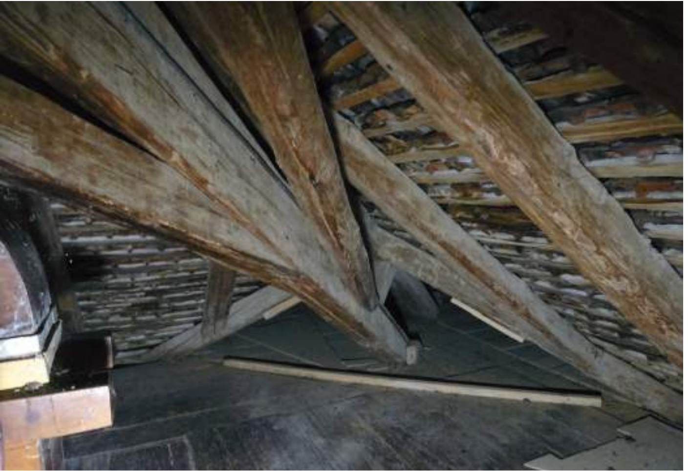
Gebäudeecke im Walmgeschoss
