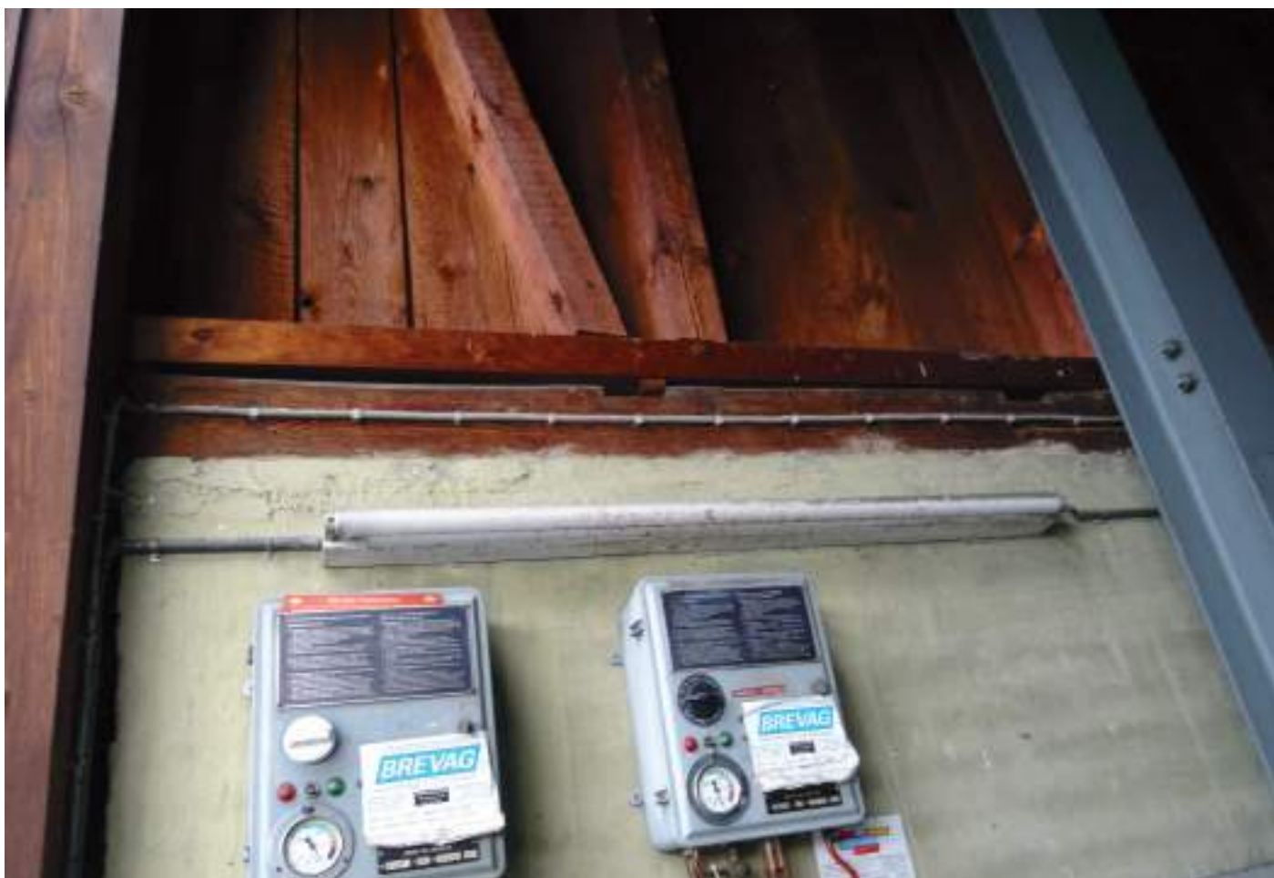
Lastwagengarage Nordwand, alte Fusspfette mit Blattsassen, darauf Schwelle der Erhöhung zur Lastwagengarage
