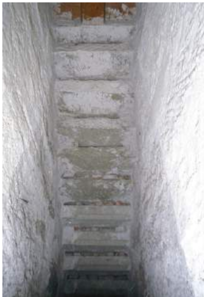
Nordtreppe unterer Teillauf, Untersicht mit wiederverwendeten Tritten Oberer Teillauf
