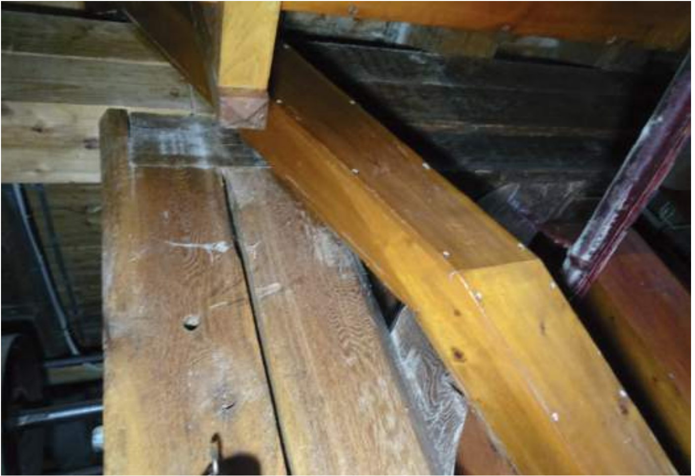
Doppelstütze und Zusammenschluss originaler (rechts) und jüngerer Unterzug (links)
