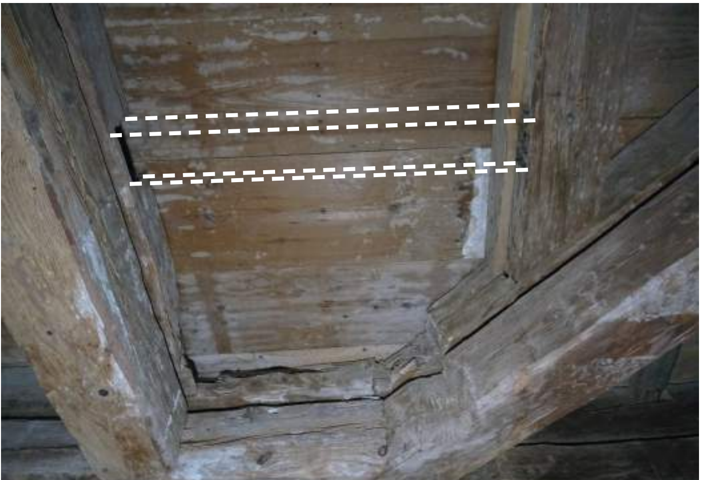
Spuren einer Kaminausrollung eines zweiten Kamins wie im 2. OG
