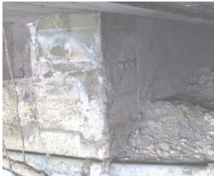
Eine Stützmauer und ein offener Anbau auf der Südseite
