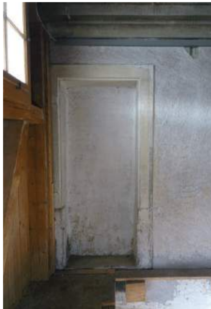
Risalitsüdwand 2. OG, vermauerte Tür (urspr. Fenster) zu Raum B, Aussenseite
