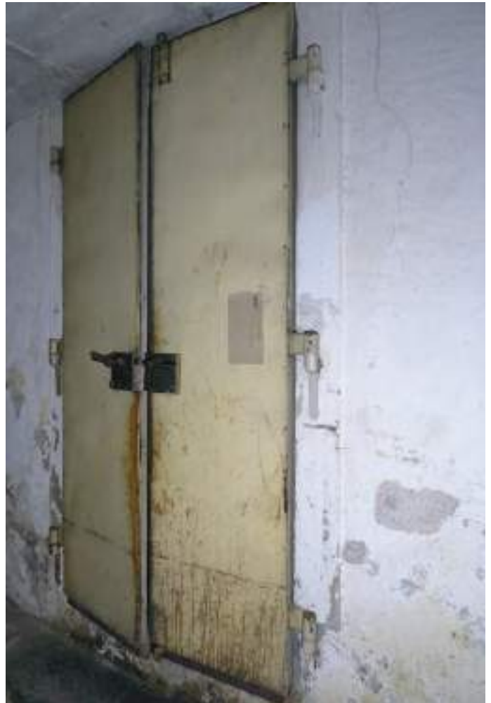
Die heutige Türe vom Südanbau in die Mühle, die Gewände reichen nicht bis auf den Boden
