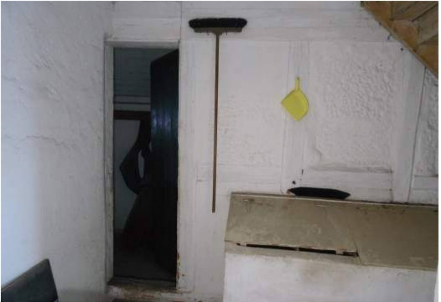
Raum E1, Westwand mit um 1939-40 herausgebrochener Tür in die Geschirrkammer
