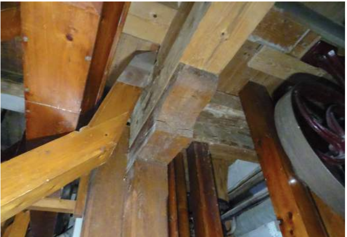
Die versetzte Doppelstütze und jüngerer Unterzug
