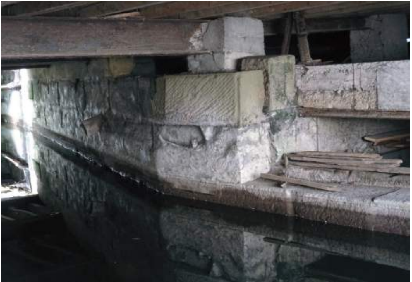
Mühlekanal, Westseite, Mündungsstelle der Quermauer Richtung Rörswilstrasse
