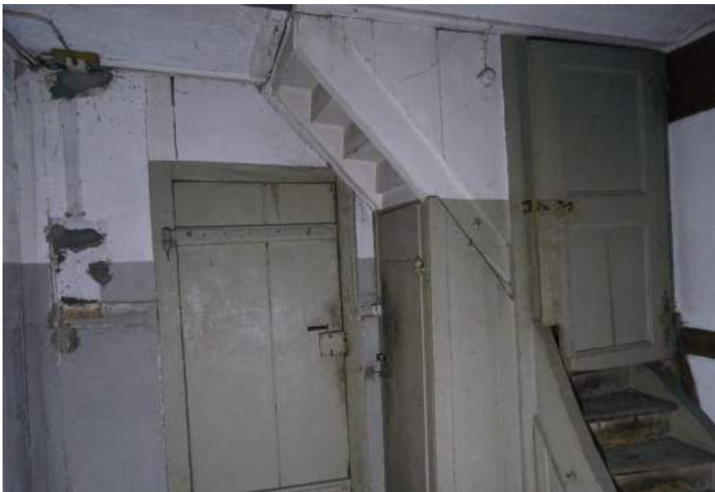
E4, Blick Richtung Norden
