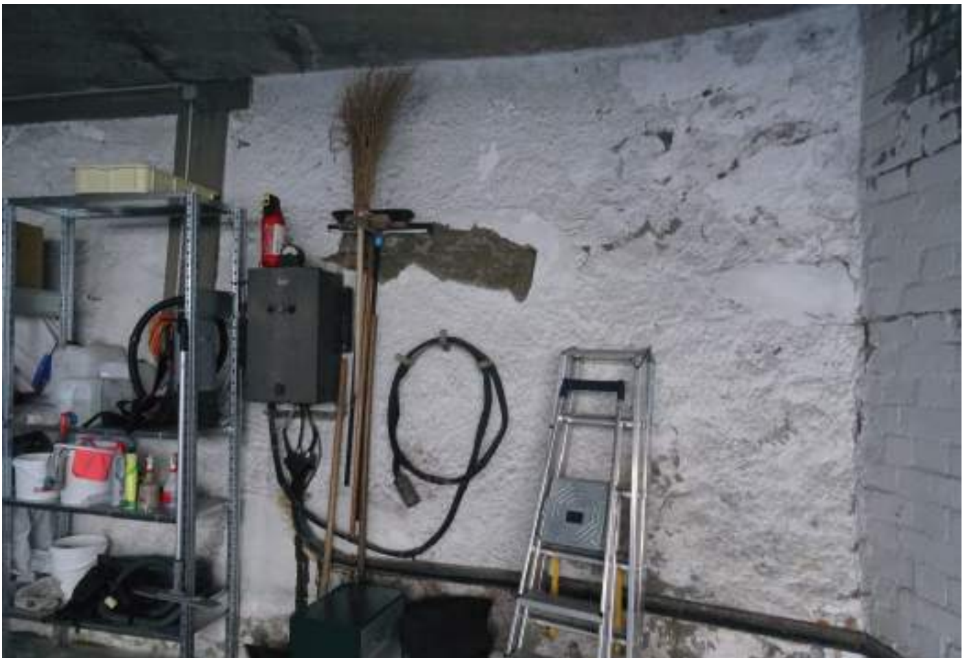
Die alte Rückwand des Lumpenschuppens ist erhalten
