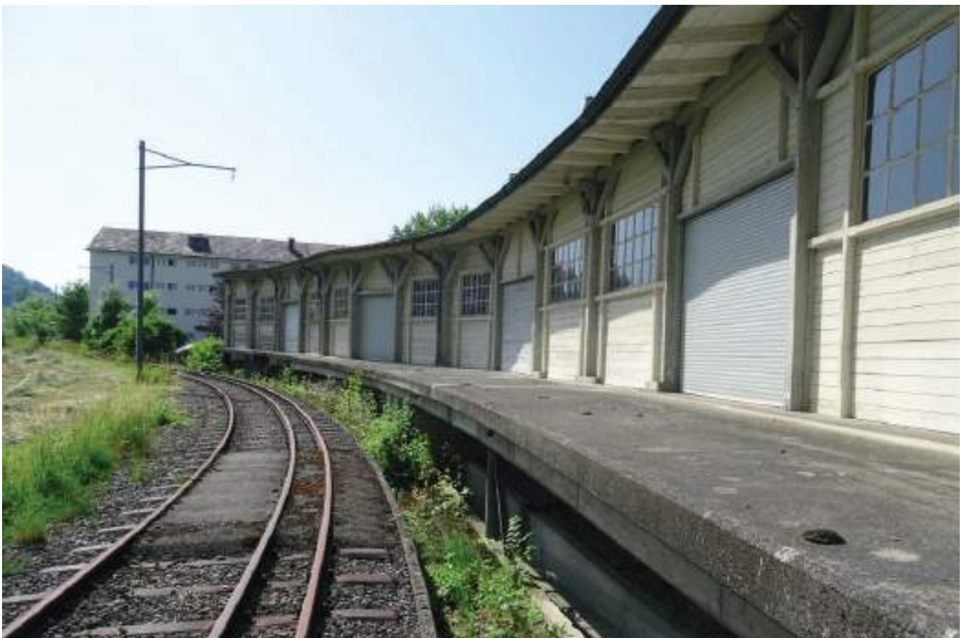
Halle 23, bahnseitige, unregelmässige Fassade
