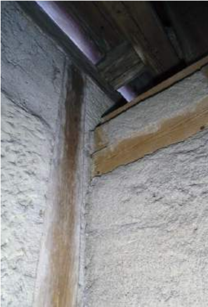
Anschluss Wohnungsdecke Phase 2 an Aussenwand Phase 1
