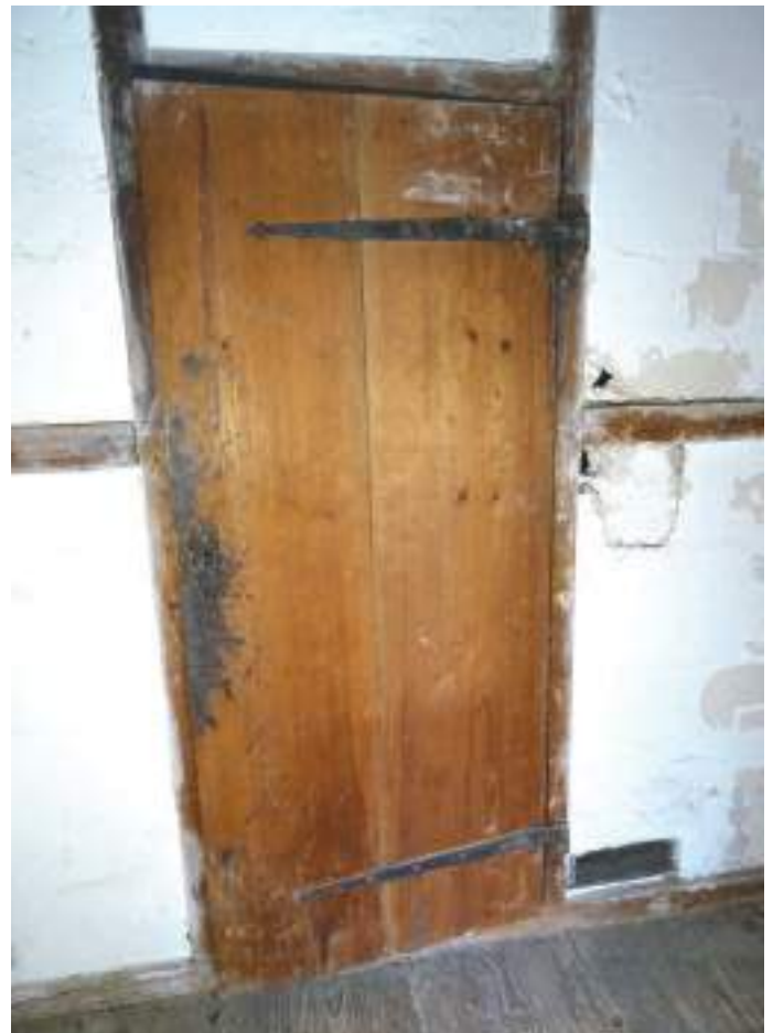
Raum F, Westwand, Tür mit Langbändern zur kleinen Kammer
