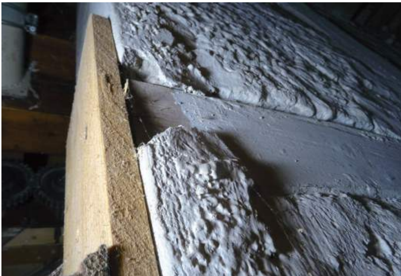
EG, die Fachwerkwand nördlich der Mittelstützen, ihr Südende ist ohne Pfosten, der Riegel läuft ins Leere
