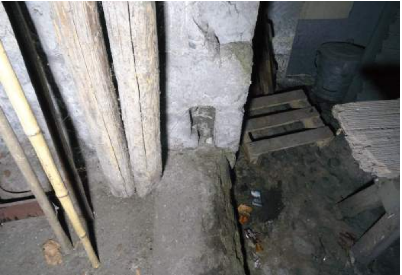
Korridorförmiger Raum südlich des Risalits und des Anbaus, Bodenschwelle und Loch zur Befestigung einer Schwelle, Nordseite (Risalitecke)
