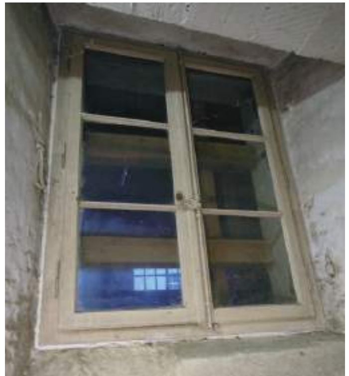
Fensterleibung mit Stützkloben und Einhängenhaken
