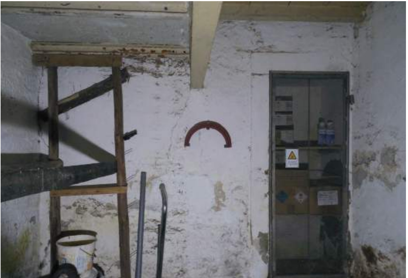
Der Anbau, Blick Richtung Westen mit ehem. Öffnung zum Risalit Süd
