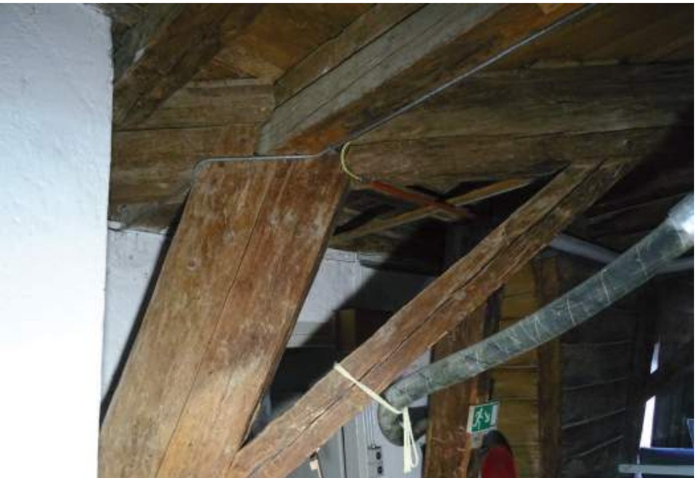
Mansartgeschoss, Strebe innere Gebäudeecke
