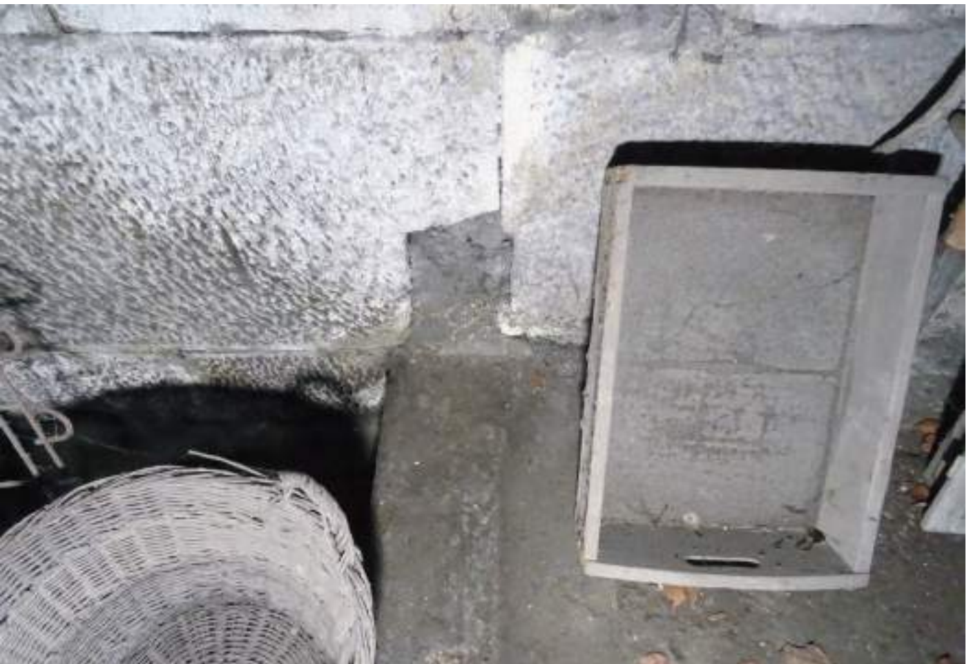
Korridorförmiger Raum südlich des Risalits und des Anbaus, Bodenschwelle und Loch zur Befestigung einer Schwelle, Südseite
