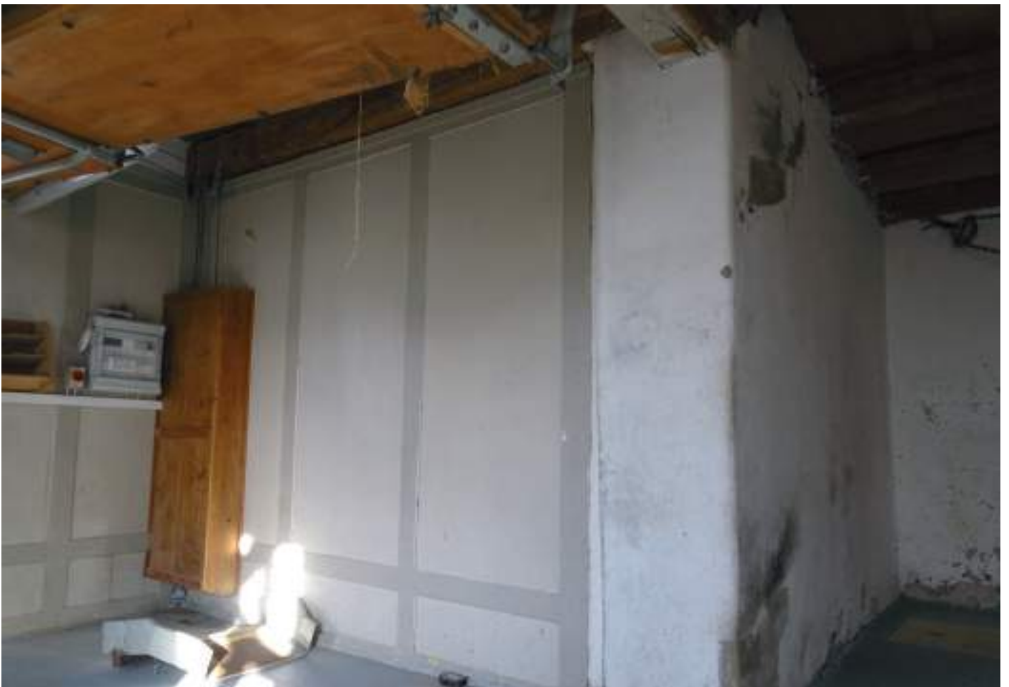
Risalit Süd 1. OG Nordostecke mit Raum A
