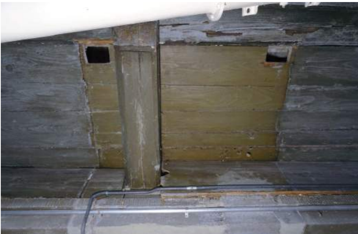
Risalitsüdfassade, Dachuntersicht, Pfostenlöcher Abort, und Deckenanstrich
