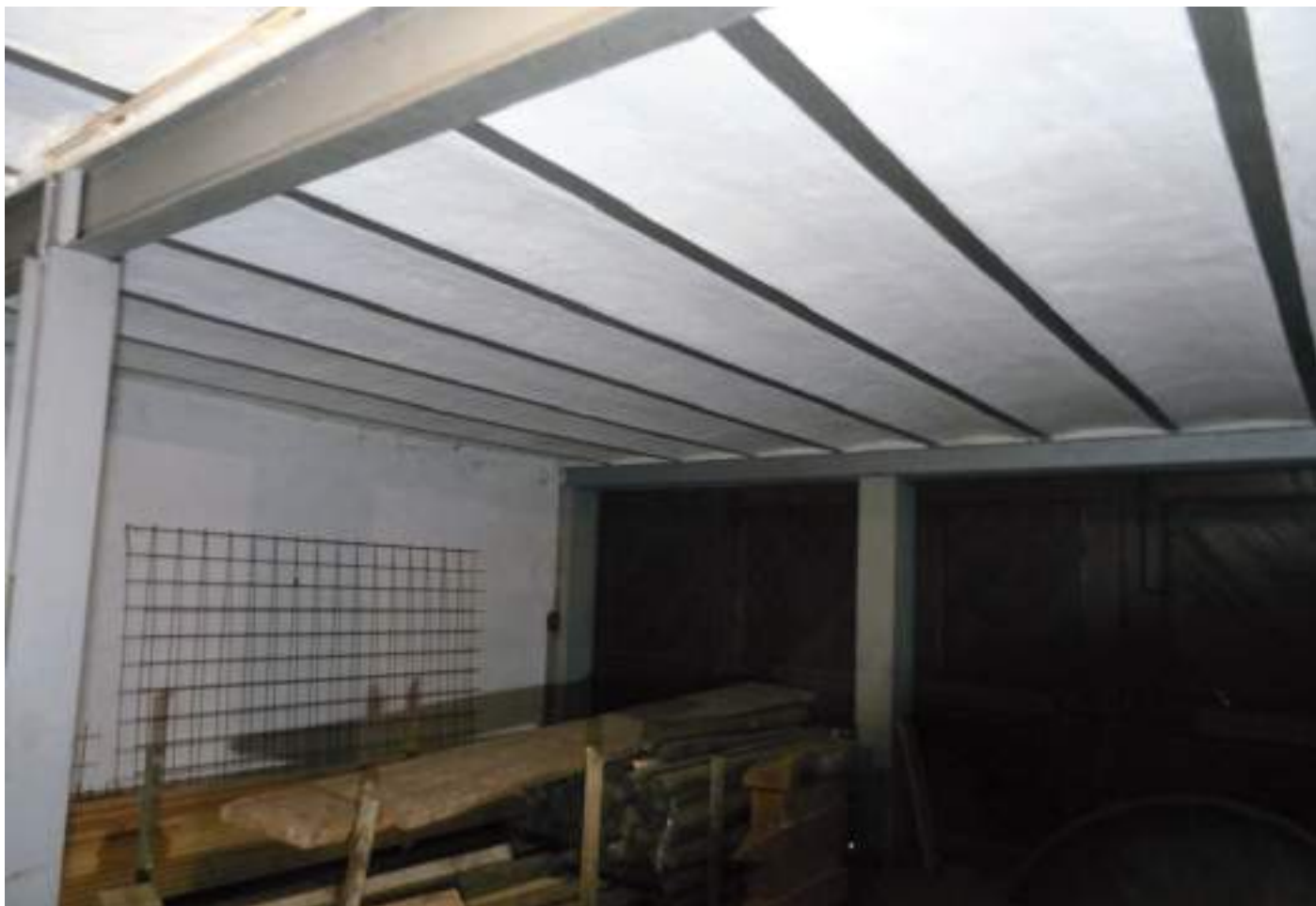
Raum E3 , Blick Richtung Westen
