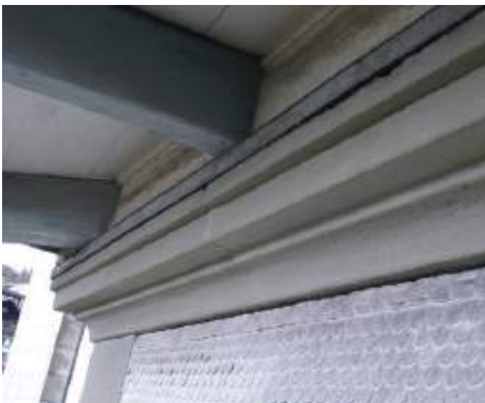
Kranzgeimse am Ostende der Nordfassade
