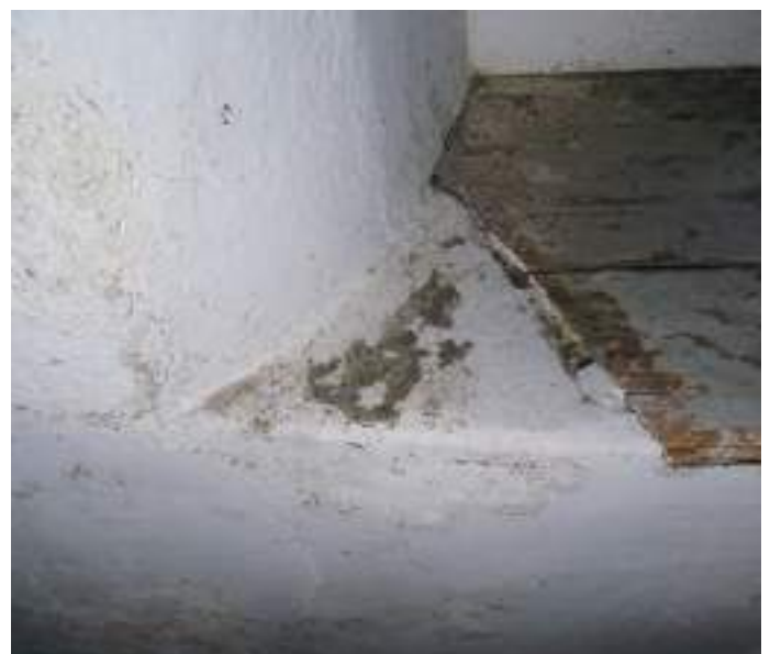
Halle EG, Westseite, 2. Fenster von Norden, mit Spuren des abgebrochenen Wohnungstrennwandanschlusses
