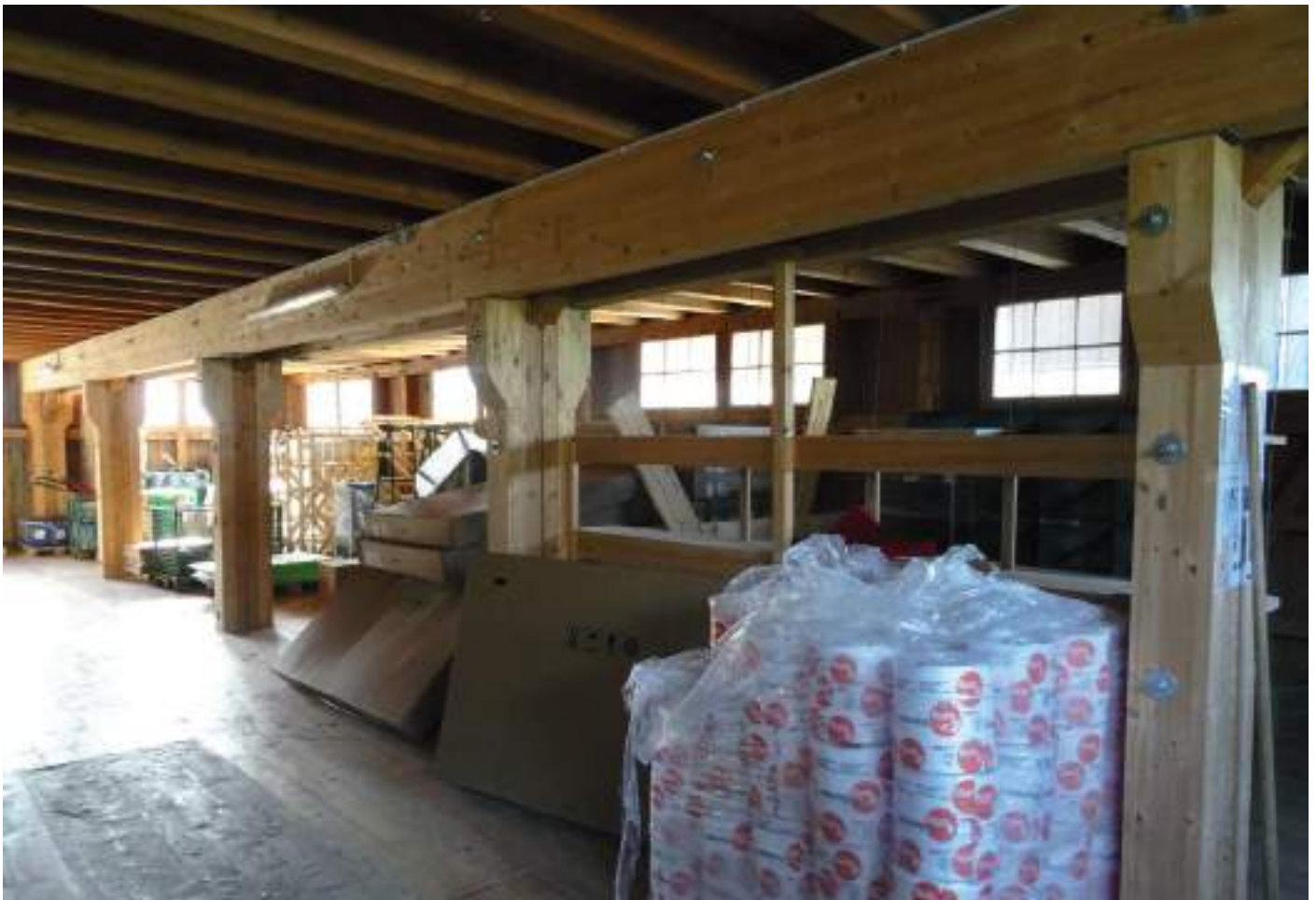
Halle 20, Erdgeschoss, verstärkte Tragstruktur
