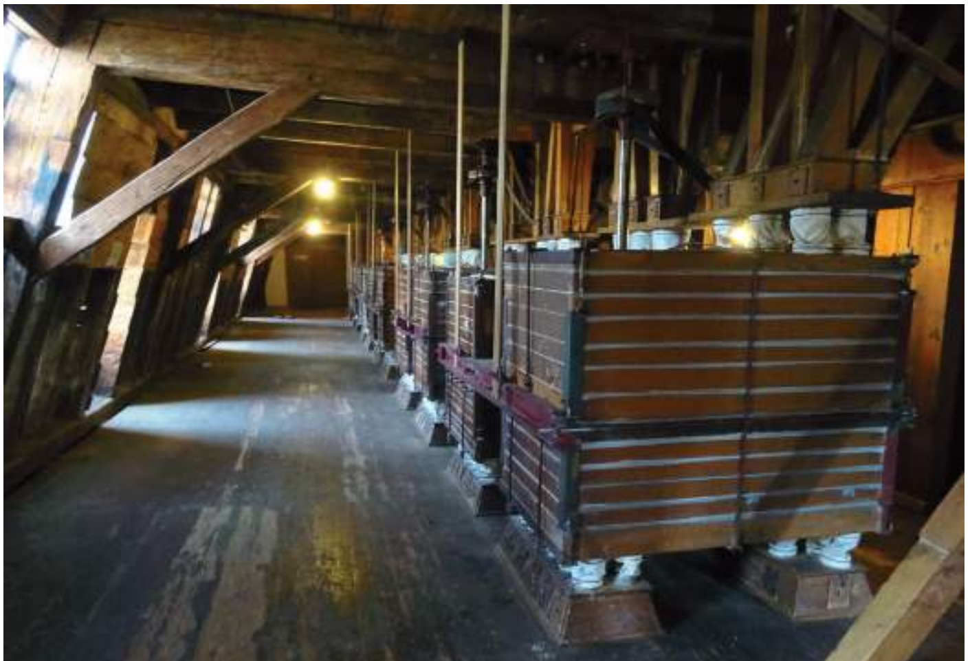
Mansartgeschoss, Westschiff, Blick Richtung Norden
