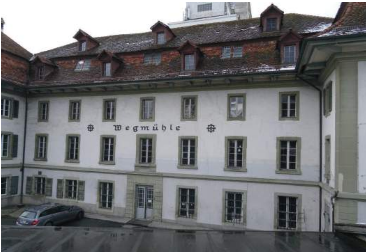
Westfassade, die beiden EG-Fenster der Wohnung (links aussen) zeigen höher liegende Brüstungen
