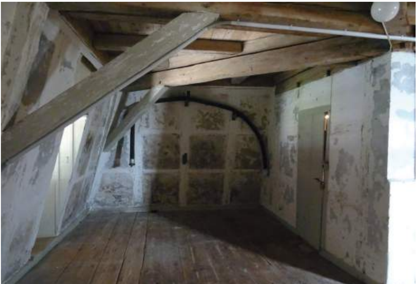
Raum A, Blick Richtung Norden
