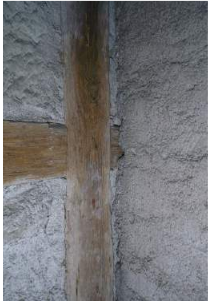
Anschluss Wohnungsrückwand Phase 2 (Ostwand) an Aussenwand Phase 1
