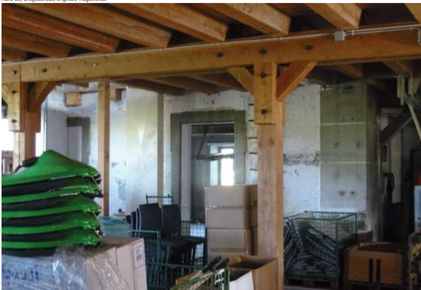
Halle 20, Erdgeschoss, originale Tragstruktur
