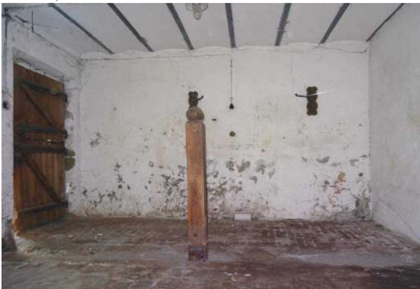
Raum E2 Blick Richtung Westen
