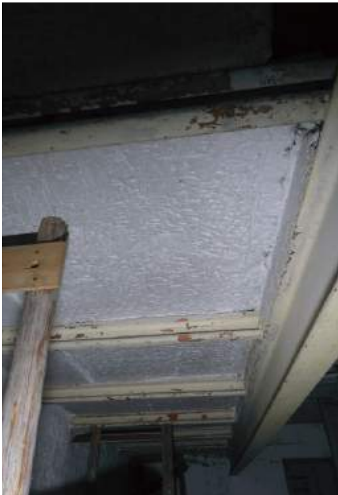
Die Untersicht des Podests mit grossformatigen Sandsteinplatten
