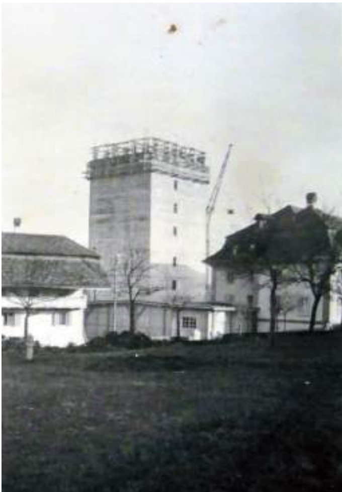
Silo 1 im Bau (Familienarchiv Reinhard)
