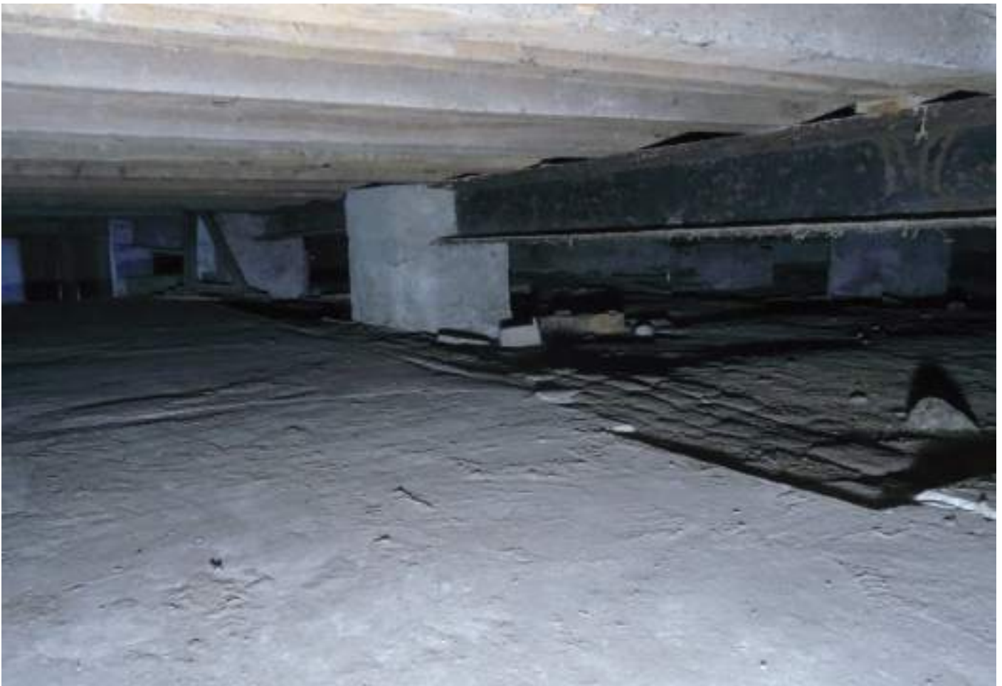
Der Podestboden mit gestocktem Zementbelag
