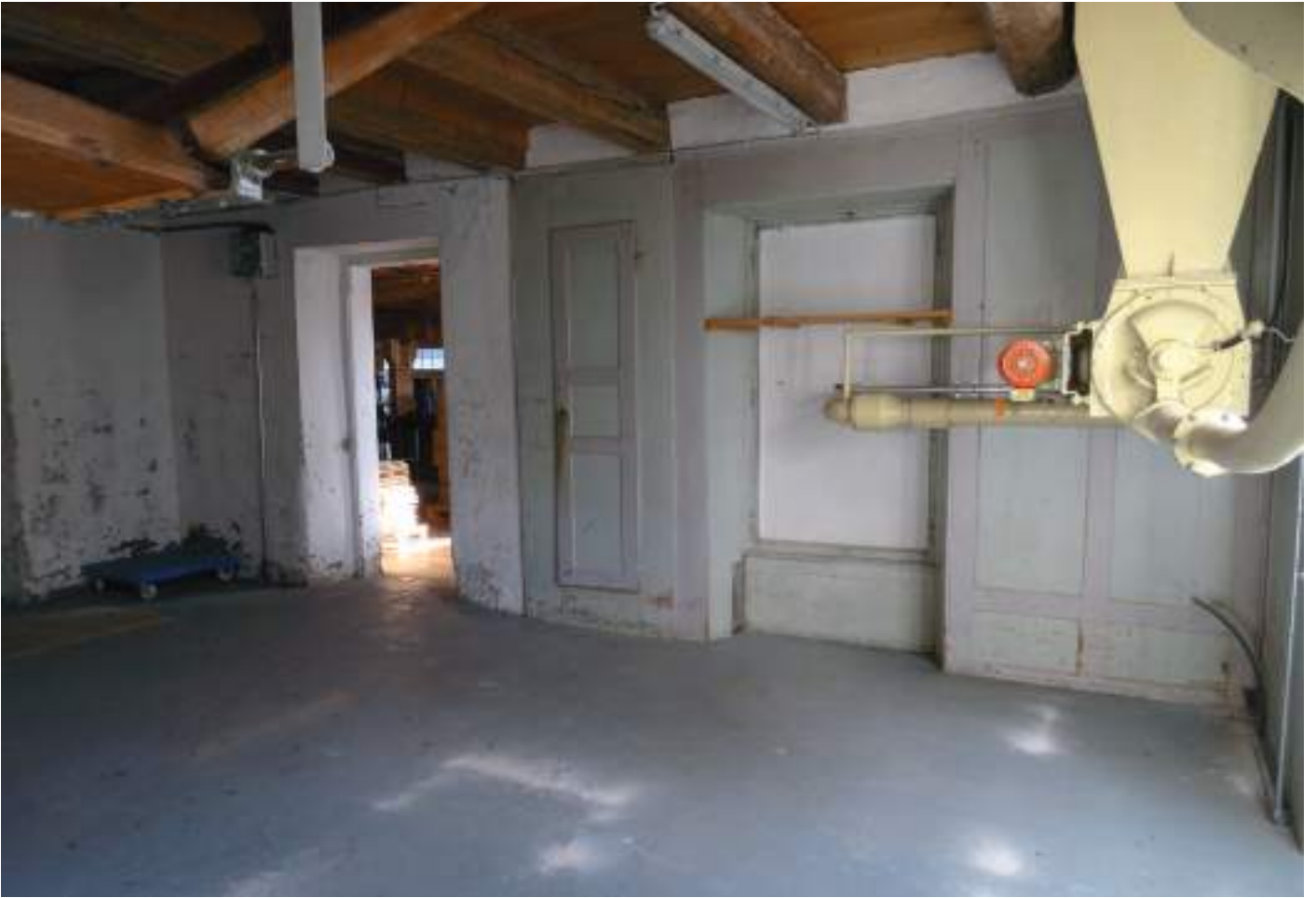
Südrisalit, 1. OG, Südwand mit spätklassizistischen Täfern 2. Hälfte 19. Jh.
