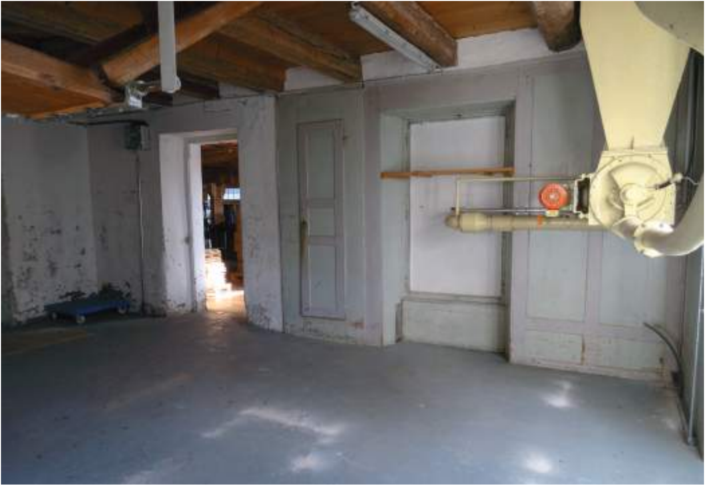
Risalitsüdwand 1. OG, links Raum C und rechts Raum B
