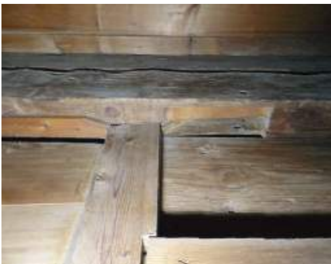
Raum F, Blattsasse des entfernten Bugs im Bereich des linken Türpfostens
