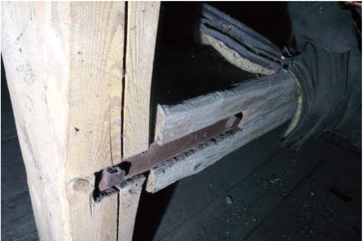
Anschluss Wohnungsdecke Phase 2 an Aussenwand Phase 1
