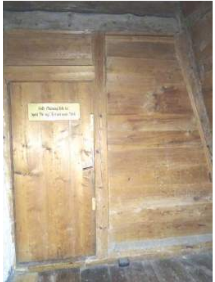
3. OG, Wand von der Halle zum Risalitraum F
